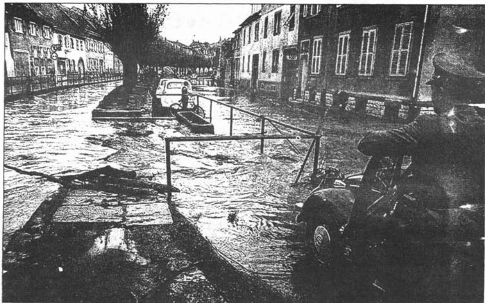
MIT ÜBERSCHWEMMUNGEN setzte der Walzbach Teile von Weingarten immer wieder unter Wasser. Eine Schwachstelle war der Bereich an der Alten Post und an der Kanalstraße. Foto: Archiv Steinert
