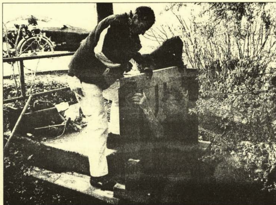
RESTAURATIONSARBEITEN leisteten Bedienstete des städtischen Bauhofs und Wolfgang Biedermann am Dorfgraben-Stellwerk im Grombach bei Büchenau. Foto: ag
