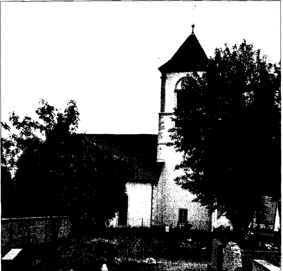
Der Turmbereich der evangelischen Kirche in Flinsbach stammt teilweise noch aus dem Mittelalter, das Langschiff aus dem Ende des 18. Jahrhunderts. Foto: Becker
