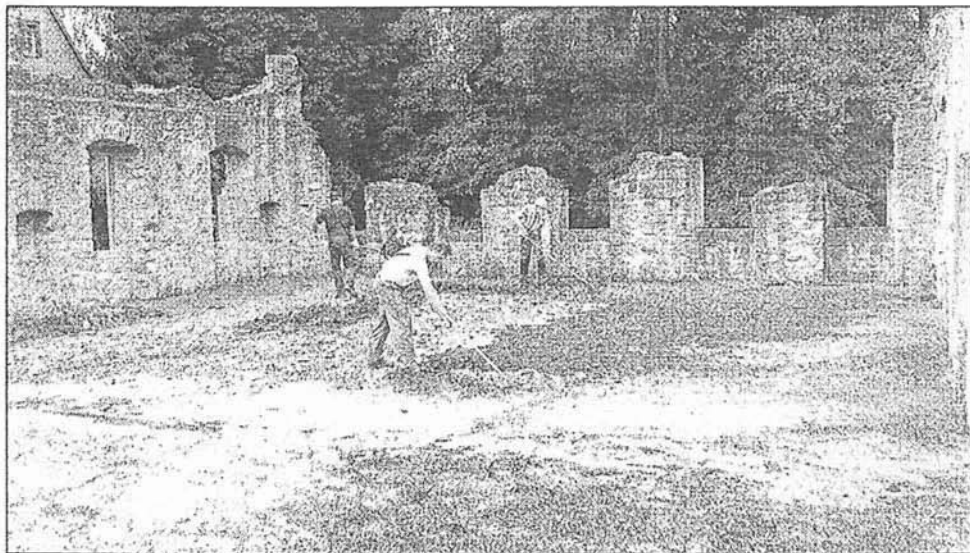
Das Abrechen von Moos war eine der Arbeiten auf der Schlossruine. Foto: Glasbrenner
