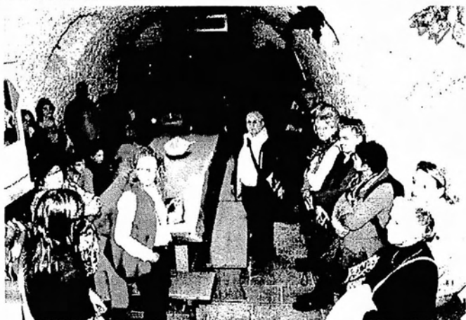
Der Gewölbekeller unter dem Gasthaus „Krone“ ist zu einem privaten Feierraum umgestaltet. Das Kalksteinmauerwerk wurde hier verputzt.
