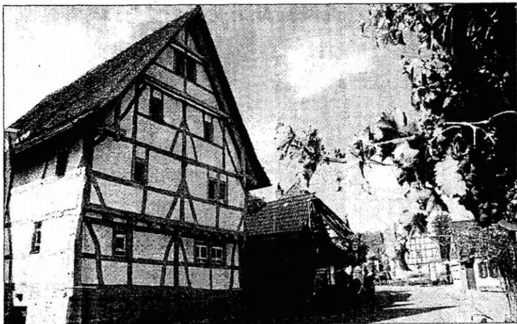
DAS 560 JAHRE ALTE FIRSTSTÄNDERHAUS in Zeutern gehört zu den bedeutendsten Kulturdenkmälern in der Region. Zwischen 2003 und 2007 wurde das Gebäude mit großem bürgerschaftlichem Engagement renoviert. Foto: psp
