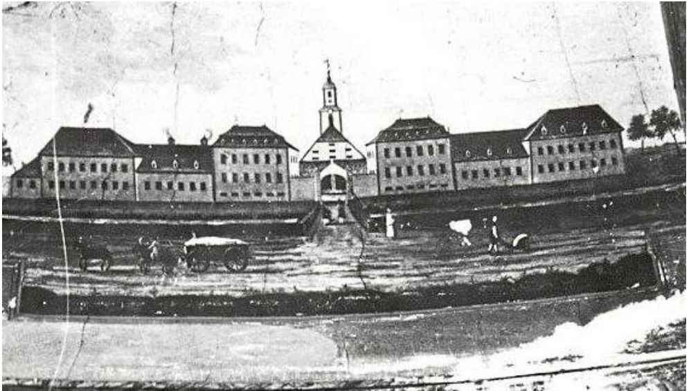
Die Hauptgebäude der ehemaligen fürstbischöflichen Saline nach einem Fresko im Gartenpavillon der Salinenanlage. Foto: Habermann/Stadtarchiv Bruchsal
